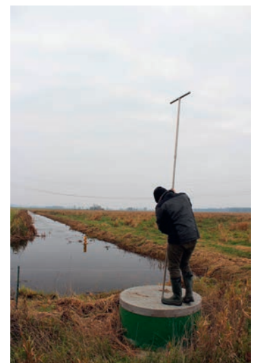
Abbildung 6: Stauanlage 1a1 vom Typ „Welse“ wird für den Volleinstau vorbereitet. Foto: J. Brodersen
