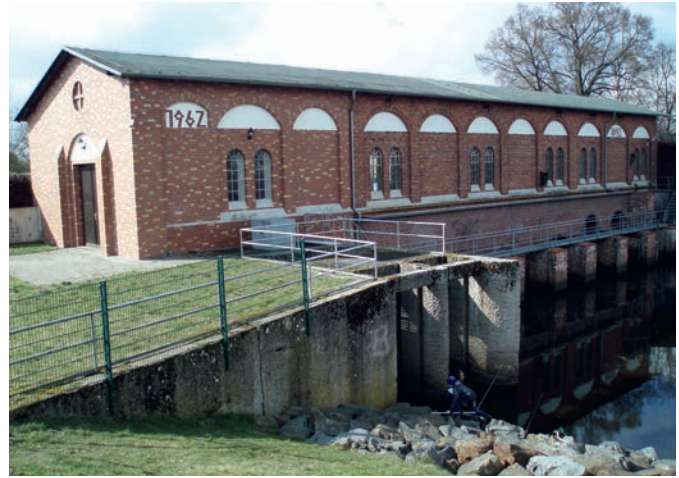
Abbildung 4: Schöpfwerk Schwedt I, eines der beiden Schöpfwerke des Nasspolders A/B. Foto: Michael Tautenhahn
