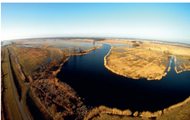
Abbildung 9: Großflächige Überflutungen im Polder 5/6, Aufnahme vom 16.03.2016. Foto: D. Wiedig
