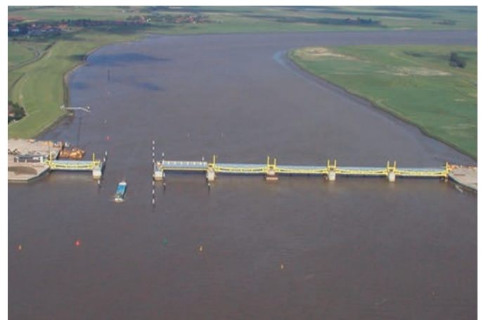
Abbildung 6: Emssperrwerk bei Gandersum (dient dem Schutz vor Sturmfluten und der Schiffsüberführung). Zukünftig sollen hier unterschiedliche Einbauten oder Steuerungsmaßnahmen zur Schwebstoffreduktion untersucht und ggf. umgesetzt werden. Foto: NLWKN
