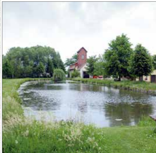
Saniertes Dorfteich und Feuerwache in Lugau, Landkreis Elbe-Elster
