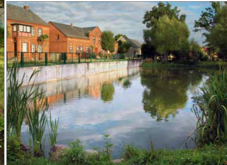
Schade, dass die straßenseitige Mauer nicht mit Feldsteinen verblendet wurde - Dorfteich in Krampfer, Landkreis Prignitz.
