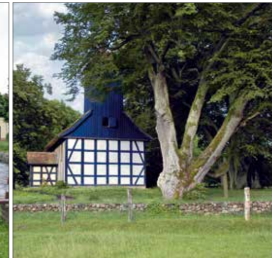
Die um 1700 errichtete Fachwerkkirche von Alt Placht, Landkreis Uckermark: Neben der Kirche stehen mehrere 500-jährige Winterlinden.
