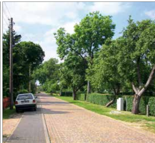
Neuverlegte Natursteinpflasterstraße in Neulitzgöricke, Landkreis Märkisch-Oderland: Hier kann das Regenwasser auf dem Seitenstreifen versickern. Auf eine Kanalisation konnte verzichtet werden.
