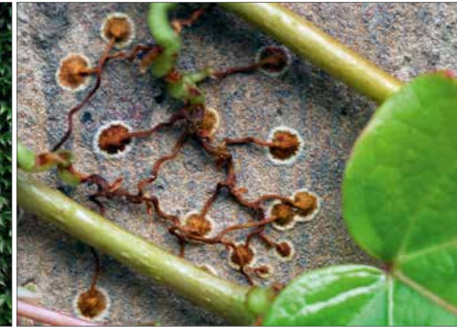
Die scheibenförmigen Wurzeln des Wilden Weins haften auf der Fassadenoberfläche, ohne dabei die Bau- substanz zu schädigen.
