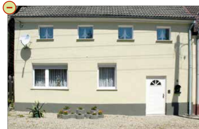
Modernisiertes Bauernhaus: Die von allen Zierelementen gesäuberte Fassade wirkt steril. Wo ein Vorgarten Platz hätte, finden sich ein fahles Kiesbett mit Anstandsgrün in Betonkübeln.
